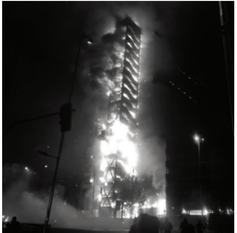
Santiago, 18/10 incendio della sede della società elettrica ENEL
