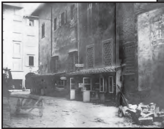
NELLA PIAZZA DELL'OLIO, DIETRO IL PALAZZO DELL'ARCIVESCOVADO E A FIANCO DELLA CHIESA DI SAN SILVESTRO, ERANO ADDOSSATE TRE LUNGHE E MODESTE STRUTTURE A TETTOIA CHE OSPITAVANO LABORATORI DI ARGENTERIA E METALLI PREZIOSI
