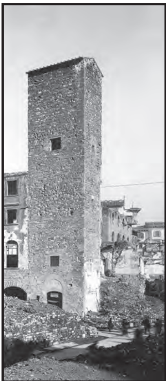
NELLA SERRATA STRUTTURA DELLA CITTÀ TRECENTESCA, CARATTERIZZATA DA VIE STRETTE E TORTUOSE, LE POTENTI TORRI CONFERIVANO UN ASPETTO QUANTO MAI SPETTACOLARE. UNA MASSICIA TORRE SUPERSTITE: QUELLA DEI BALDOVINETTI
