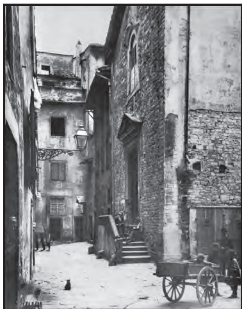
DALLA VIA DEI CAVALIERI SI ENTRAVA IN PIAZZA SANT'ANDREA, CHE OSPITAVA L'OMONIMA CHIESA, UNA DELLE PIÙ CARATTERISTICHE DEL CENTRO CITTADINO. UN DOCUMENTO RIGUARDANTE LA SUA COSTRUZIONE PORTA LA DATA DELL'ANNO 853. PARZIALMENTE DISTRUTTA DA INCENDI, FU RISTRUTTURATA E RESTAURATA NEL 1751, POI INESORABILMENTE DEMOLITA PER COSTRUIRE IL LATO MERIDIONALE DELL'ATTUALE PIAZZA DELLA REPUBBLICA. NELLA STESSA PIAZZA C'ERA LA RESIDENZA DELL'ARTE DEI RIGATTIERI E DEI LINAIOLI
