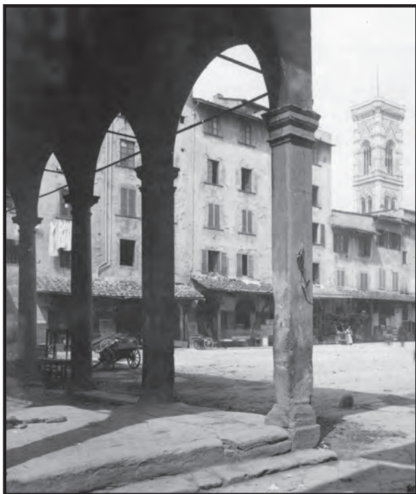
LA LOGGIA DEL PESCE VENNE SMONTATA NEL 1889 E CONSERVATA IN ALCUNI MAGAZZINI FINO AL 1956, QUANDO FU RICCOLLOCATA IN PIAZZA DEI CIOMPI
