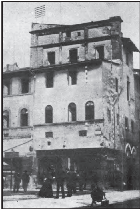
EDIFICI SULL'ANGOLO DI VIA DEGLI SPEZIALI, ANCH'ESSI DEMOLITI
