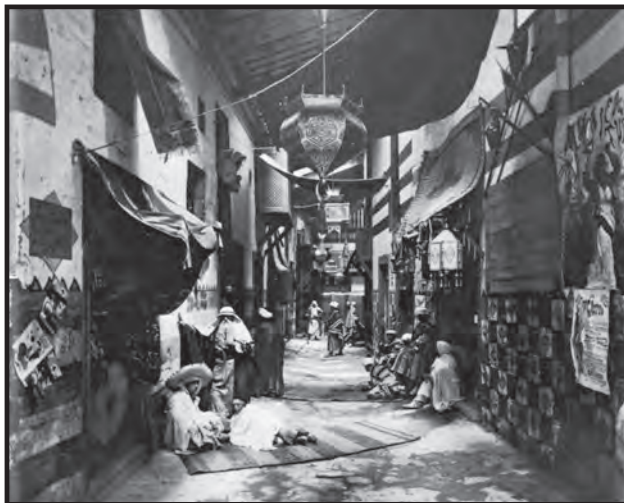
IL GHETTO FIORENTINO, ORMAI ABBANDONATO DAGLI ABITANTI, TRASFORMATO IN UNA CASBAH ORIENTALE DURANTE IL CARNEVALE DEL 1886
